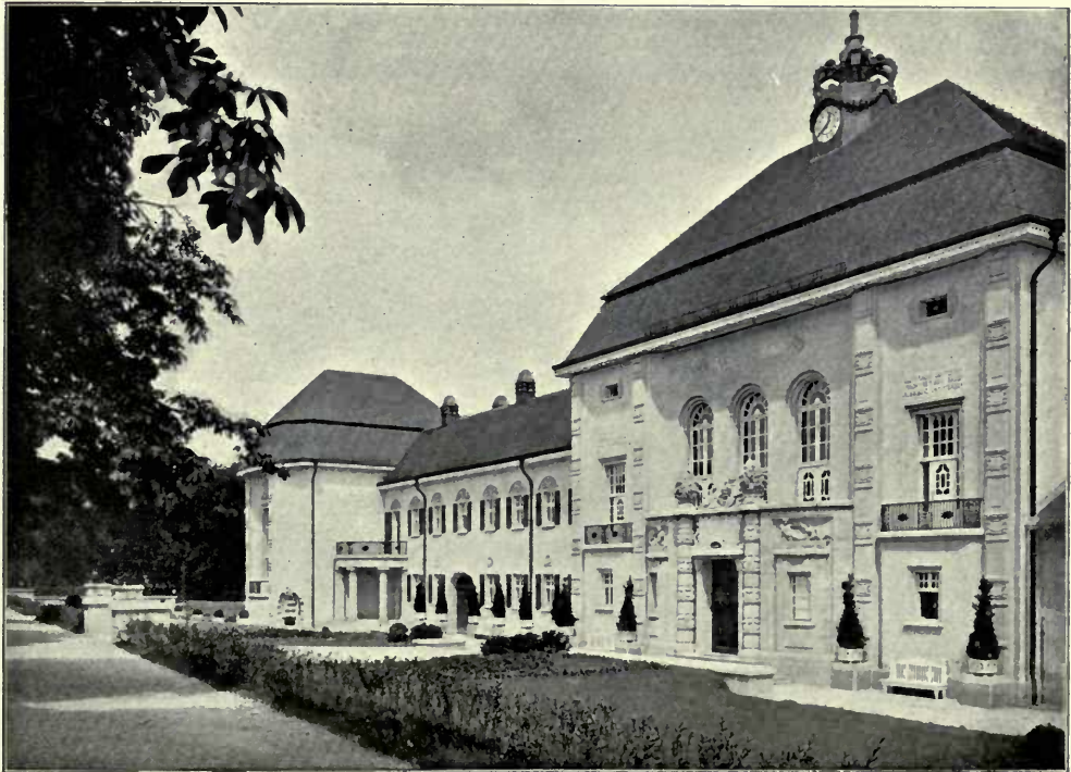
Fernheizwerk und Bad Elster, SCHILLING AND GRAEBNER, und Oberbaurat, REH, Architekten.
