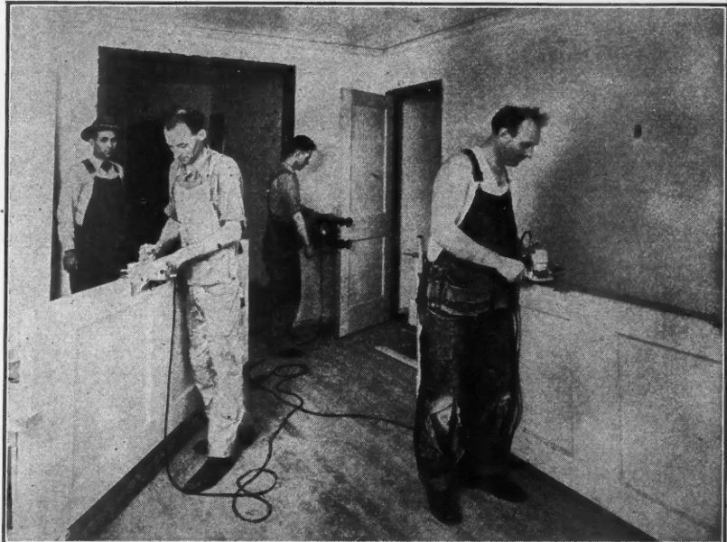
Courtesy—H. B. Marshall Construction Co., Chicago
