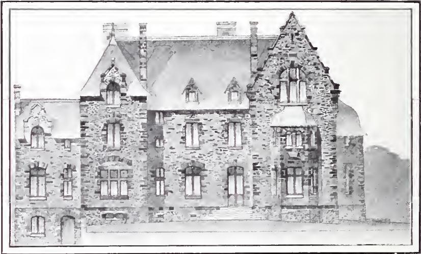
FIG. 11A. CHATEAU DE LA CHATAIGNERAIE. REAR FACADE.
